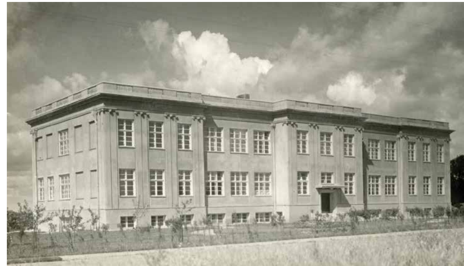
Biržų gimnazijos rūmai, pastatyti 1931 m. Aut. architektas V. Landsbergis-Žemkalnis.
